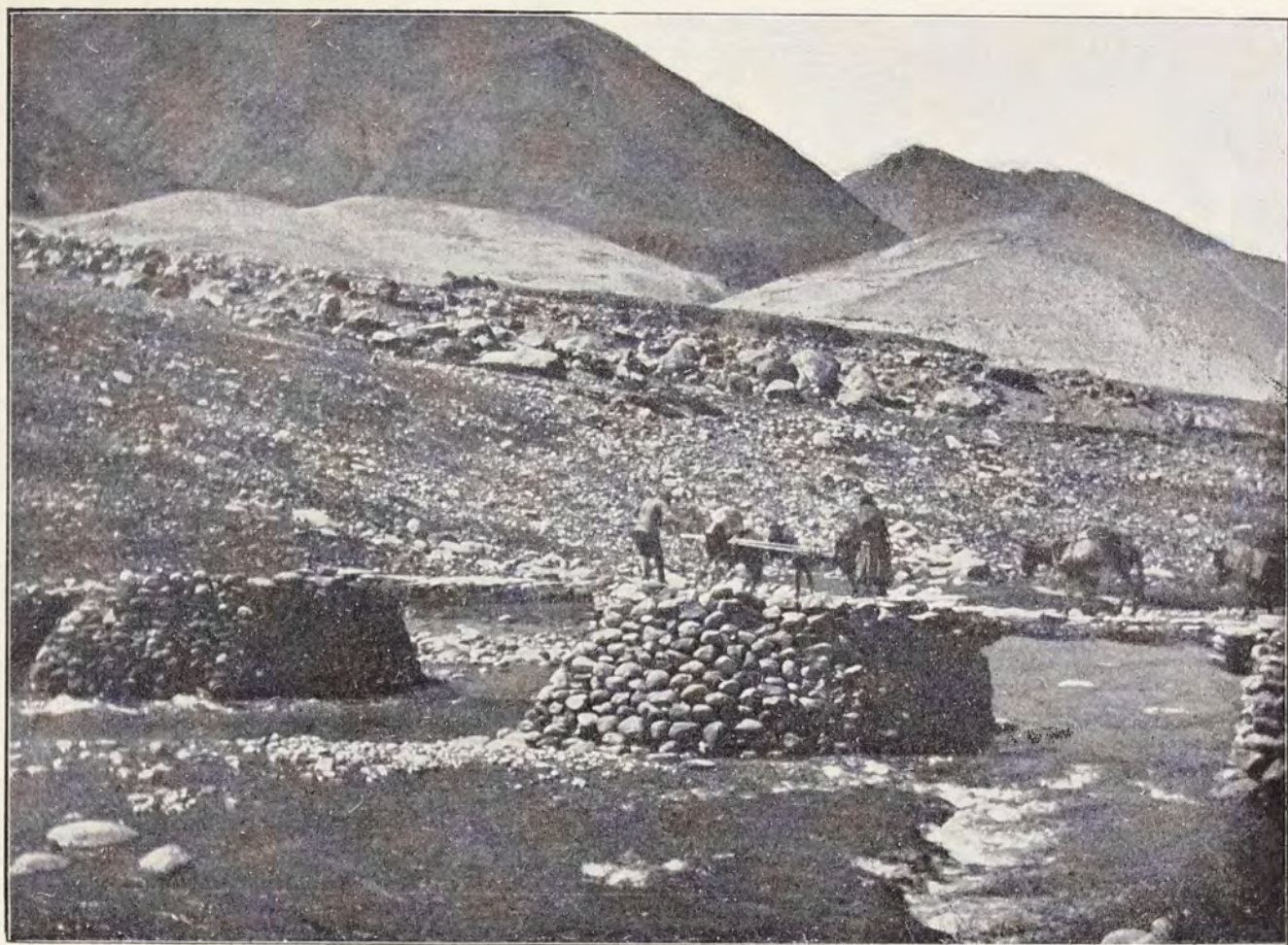
Brücke bei Dorbuk.
