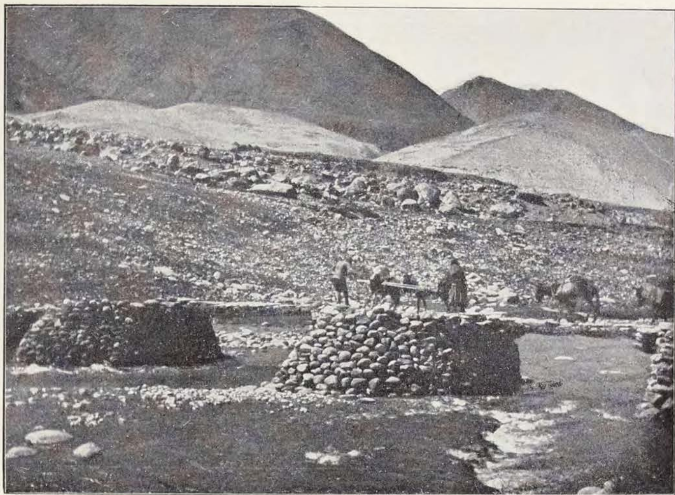
Brücke bei Dorbuk.
