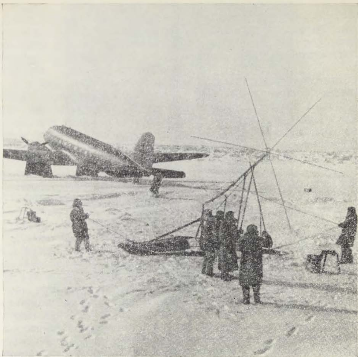
Подъем мачты автоматической станции
