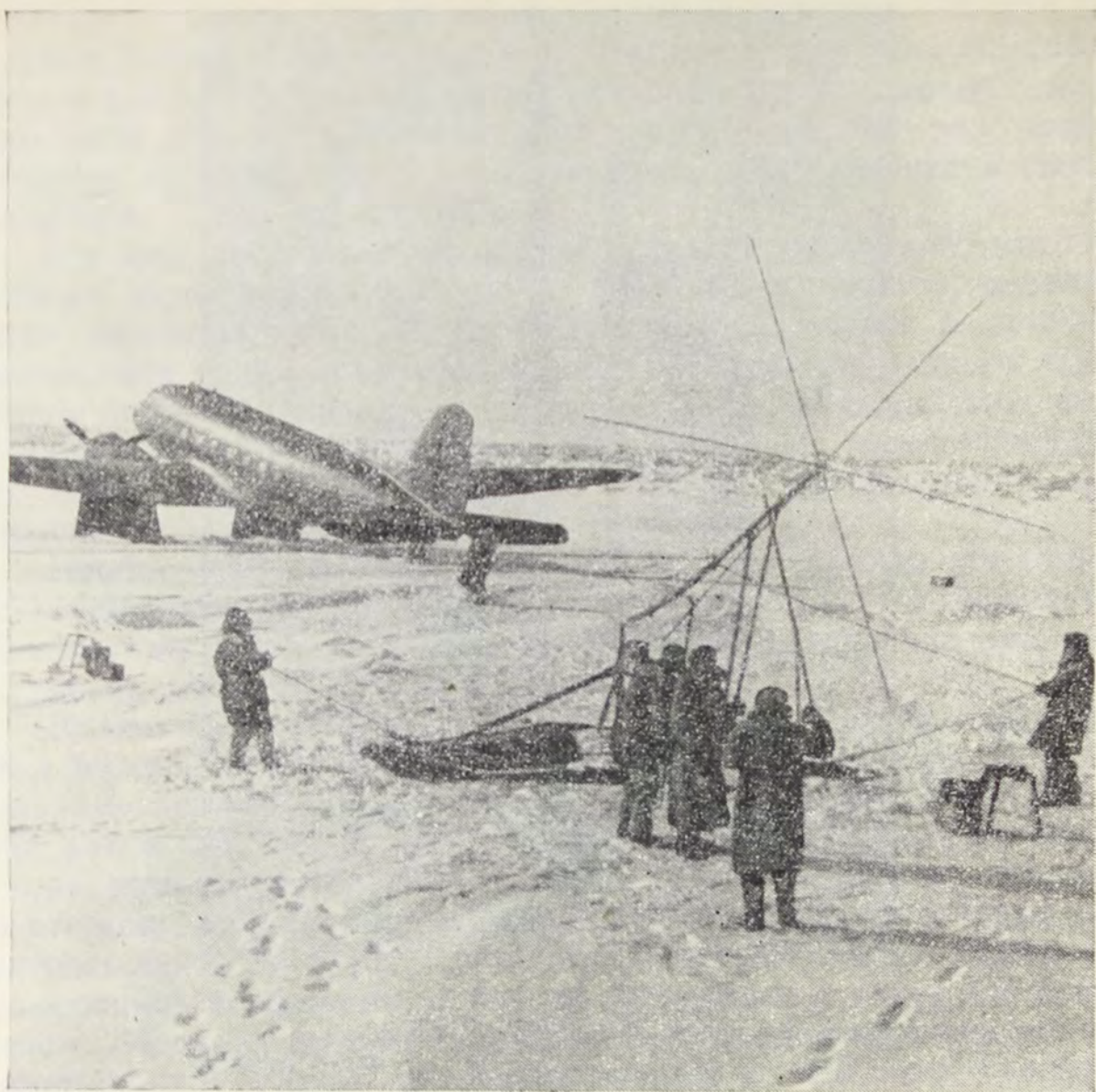
Подъем мачты автоматической станции
